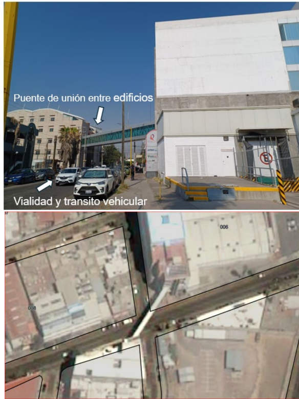
Figura 63. Accesos elevados entre inmuebles
