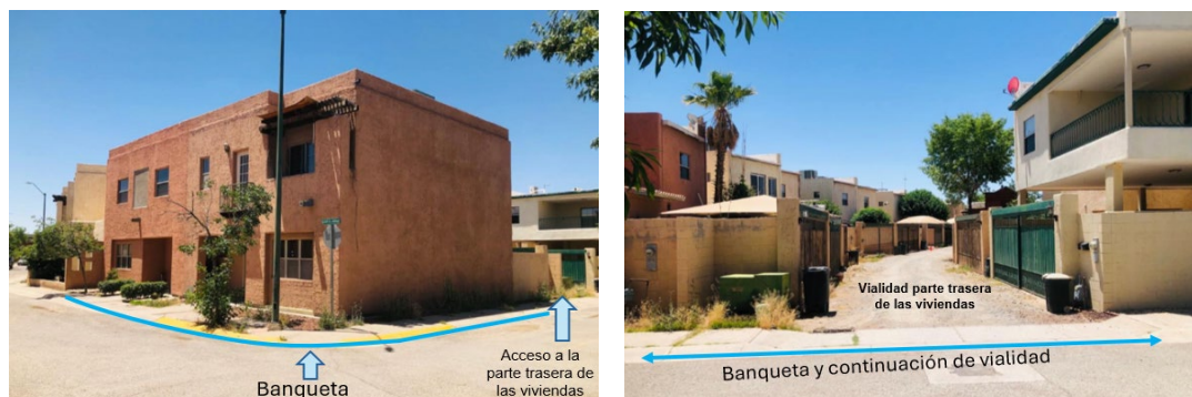
Figura 51. Acceso posterior a la vivienda
