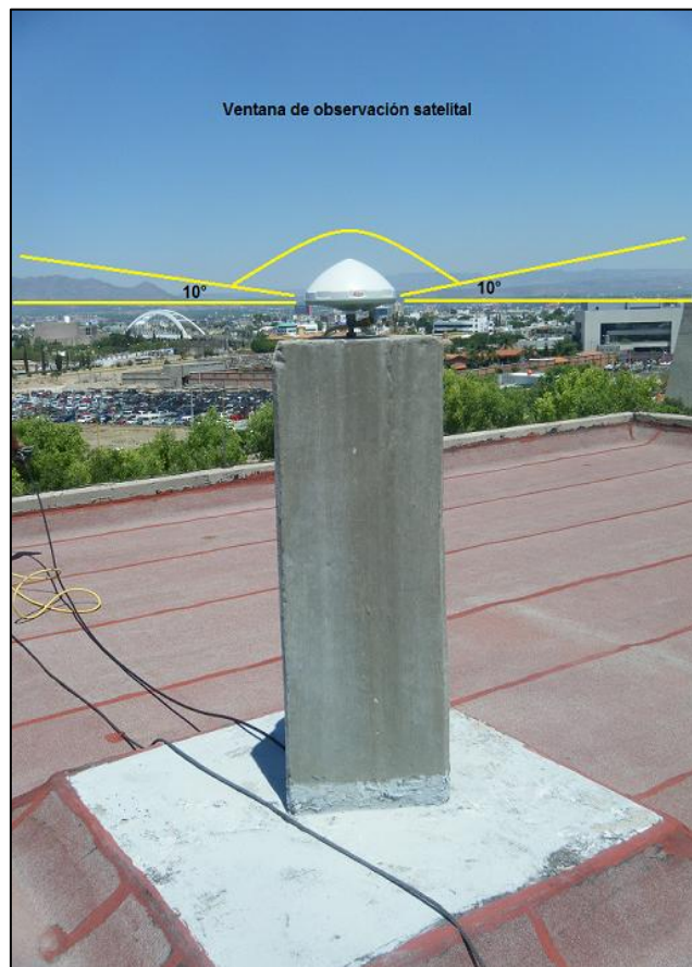
Ventana de observación satelital de una antena GNSS.
