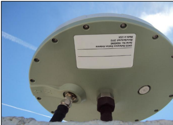
Cable coaxial conectado al puerto de una antena GNSS.
