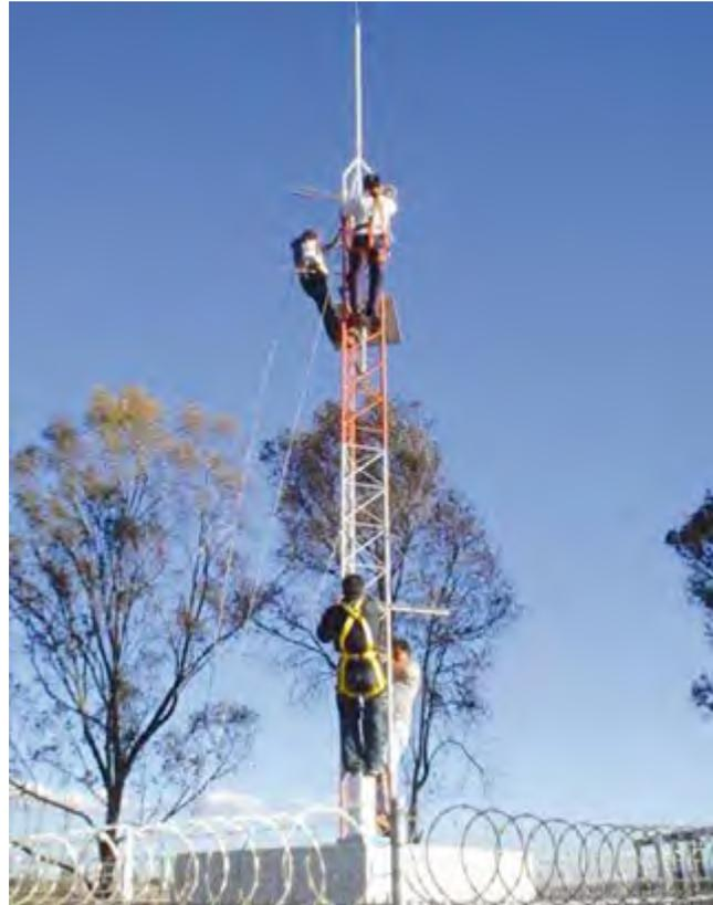
Foto 4. Instalación de la torre atirantada, panel solar y antena de comunicación de un PCD.
