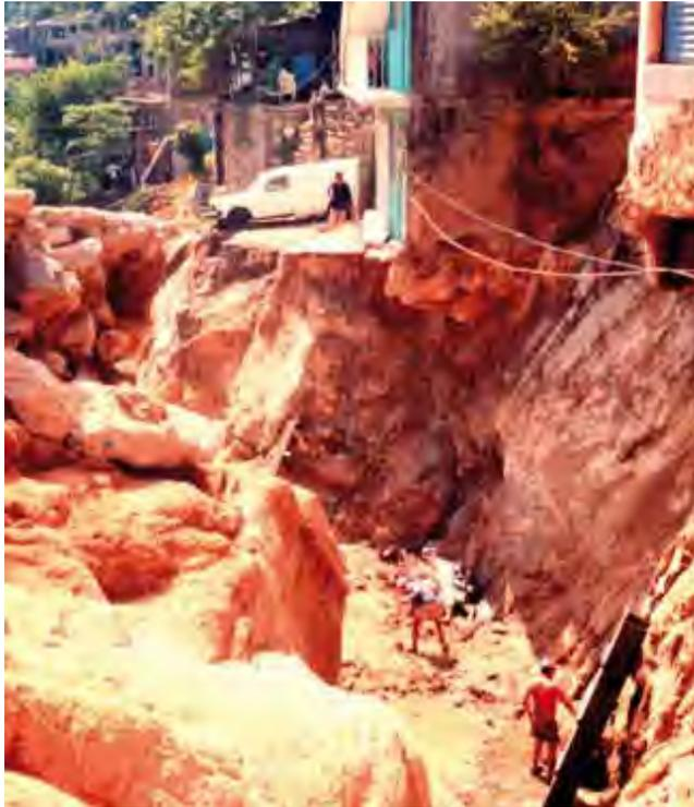
**Foto 5.** Erosión de cerca de 6 m de profundidad producida por corrientes sobre calles de gran pendiente causadas por las lluvias del huracán Pauline (1997) en Acapulco. Fotografía por M. Rosengaus.
