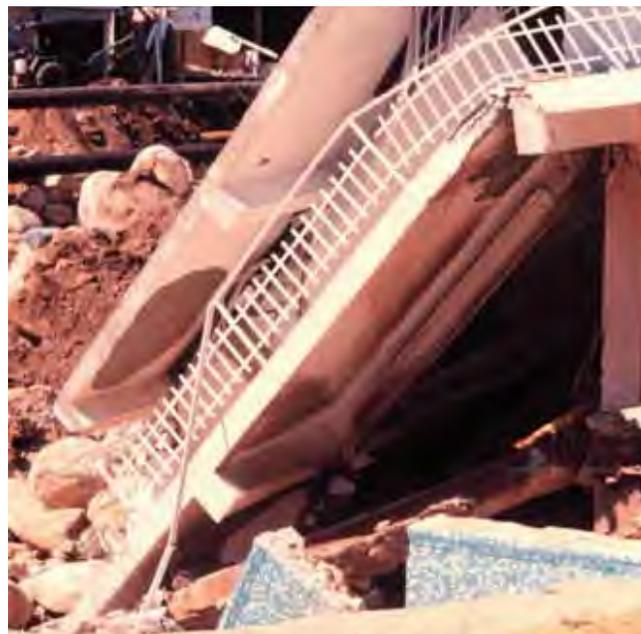
**Foto 6.** Consecuencia de ubicar la cimentación de algunas columnas de la construcción dentro del cauce de un arroyo en Acapulco durante las lluvias por Pauline (1997). Fotografía por M. Rosengaus.
